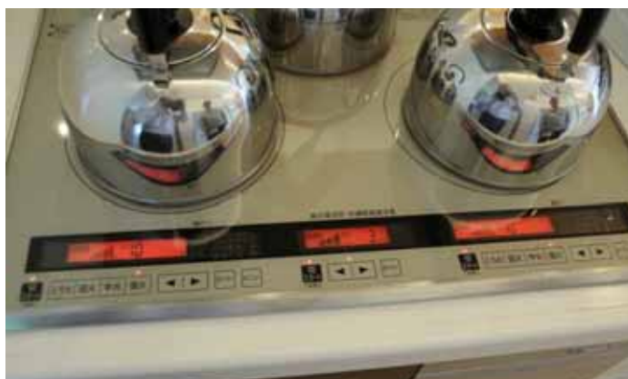
写真4 IHヒーター動作確認
