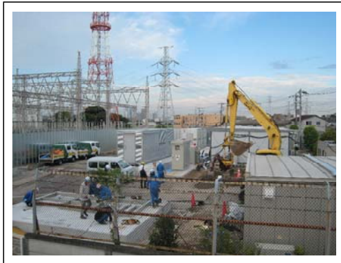
工事中の蓄電複合技術実証センター
