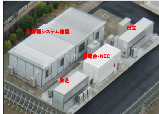
工事後の蓄電複合技術実証センター
