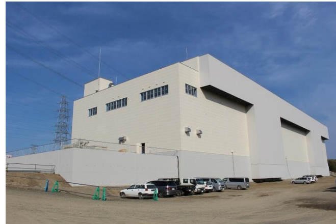
＜蓄電池建屋外観＞
